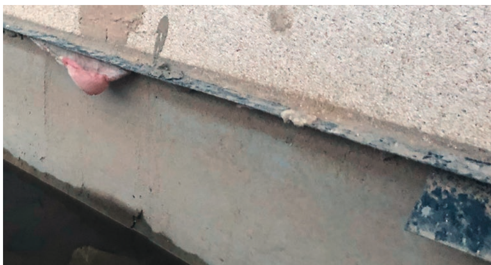
Příčné utěsnění s běžným izolačním pásem zdíva
