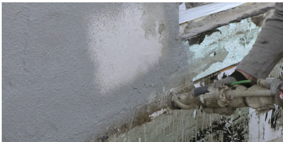
Nanesení materiálu metodou nástřiku na starou ochrannou vrstvu
